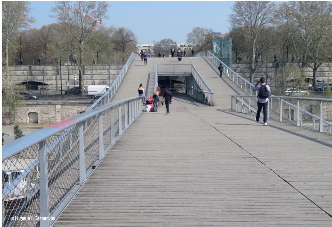
de 1,20 m y ser de directriz recta o ligeramente curva. La pendiente establecida máxima será de 6 %. La rampa de un tramo no tendrá una longitud superior a 6 m. Las rampas de más de 6 m de longitud tendrán varios tramos, dispondrán de rellanos intermedios de una anchura igual a la de la rampa y una profundidad de 1,50 m. A ambos lados y en toda su longitud, la rampa contará con un bordillo de protección de al menos 10-12 cm de altura.
