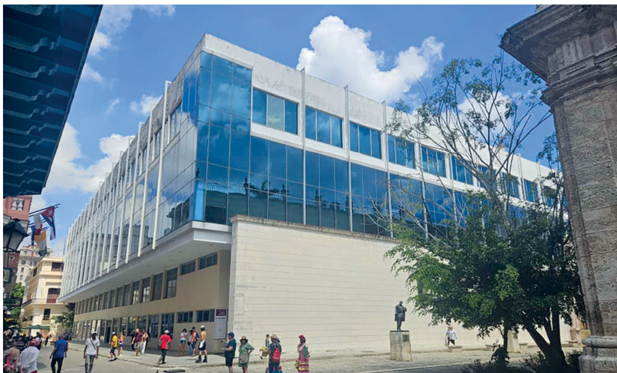
Figura 30. Algunos grandes edificios construidos o rehabilitados han incorporado fachadas de vidrio que no aprovechan la ventilación natural, y resultan en grandes consumidores energéticos.
