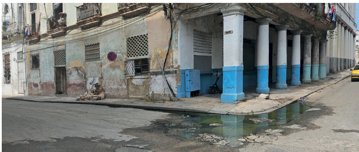
Figura 28. El estado de las redes de agua y saneamiento, especialmente en el interior de las viviendas, provoca pérdidas significativas en el agua abastecida y numerosos salideros que vierten en el espacio público.
