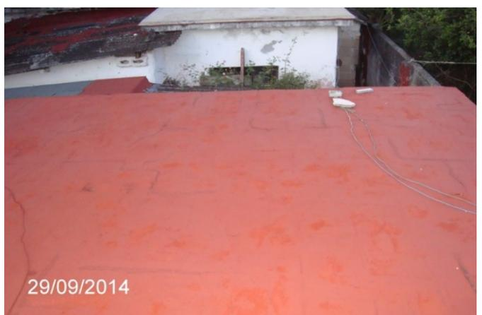
Fig. 90, 91, 92 ,93, 94 y 95. Trabajos ejecutados por el Autor utilizando la Variante No 2 propuesta, en una casa con cubierta plana de hormigón armado impermeabilizada con enrajonado y soladura, ubicada en el Municipio La Lisa, y que cuenta con 5 años sin tener filtración en dicha cubierta. Fuente: El Autor.
