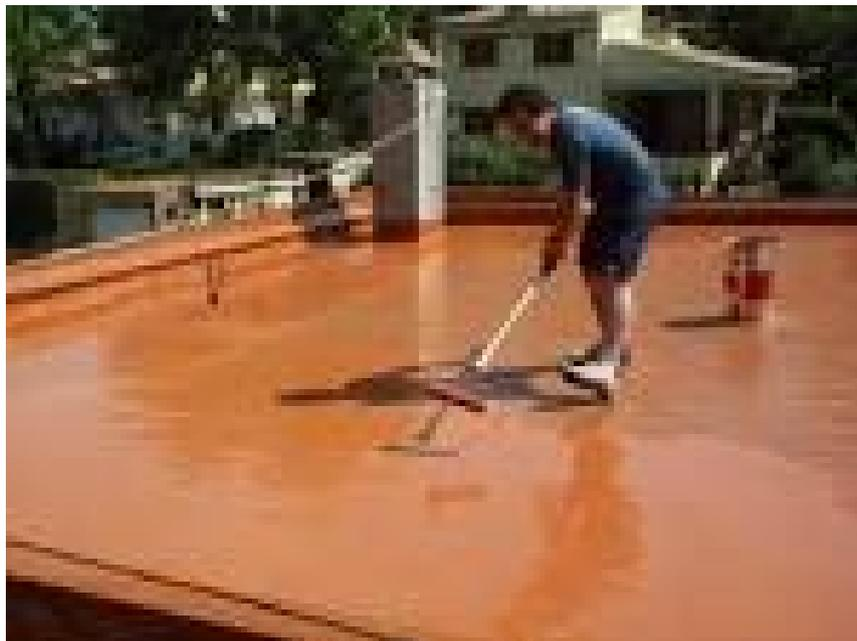
Fig. 105 Impermeabilización de cubierta con pintura elastomérica. Fuente Internet.
