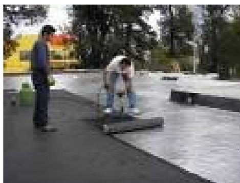
Fig.24. Colocacion de Laminas Impermeables. Fuente: Internet.
