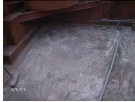
Fig. 96 y 97. Trabajos ejecutados por el Autor para preparar la superficie de la cubierta, en una casa con cubierta plana de hormigón armado impermeabilizada con enrajaondo y soladura, ubicada en el Municipio Plaza de la Revolución. Fuente: El Autor.
