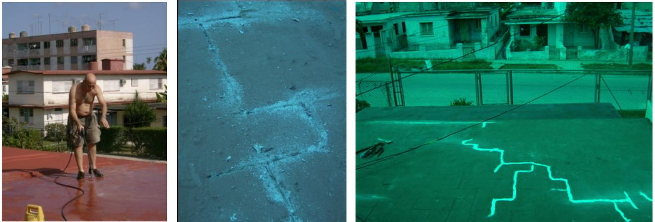
Fig. 82, 83 y 84. Limpieza de cubierta, aplicación de silicona y pintura impermeable con malla de poliéster.
