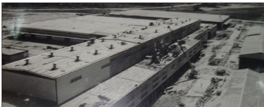
Fig. 10. Cubiertas Combinado Papeles Blancos. Jatibonico. Sancti Spíritus Utilización de sistema impermeable "built up-roofing". Fuente: EL Autor
