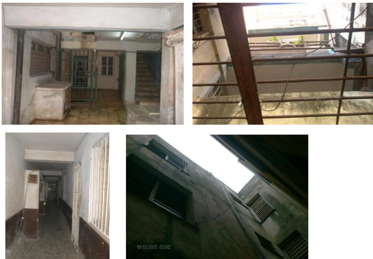
Figura 3.1. Ejemplos de Tipologías Concentrada con Vestíbulo, Patio y Patinejo. Vestíbulo de entrada, con la luz encendida de día. El bajo puntal del Vestíbulo genera zonas oscuras. A la derecha los balcones hacia el interior del patio, cerrado con rejas. Abajo tipología de Corredor lateral, ventanas de la fachada del apartamento hacia el pasillo de circulación, con un corredor muy estrecho. Pasillo de ventilación al fondo. Fuente: autora. 2013, 2015.
