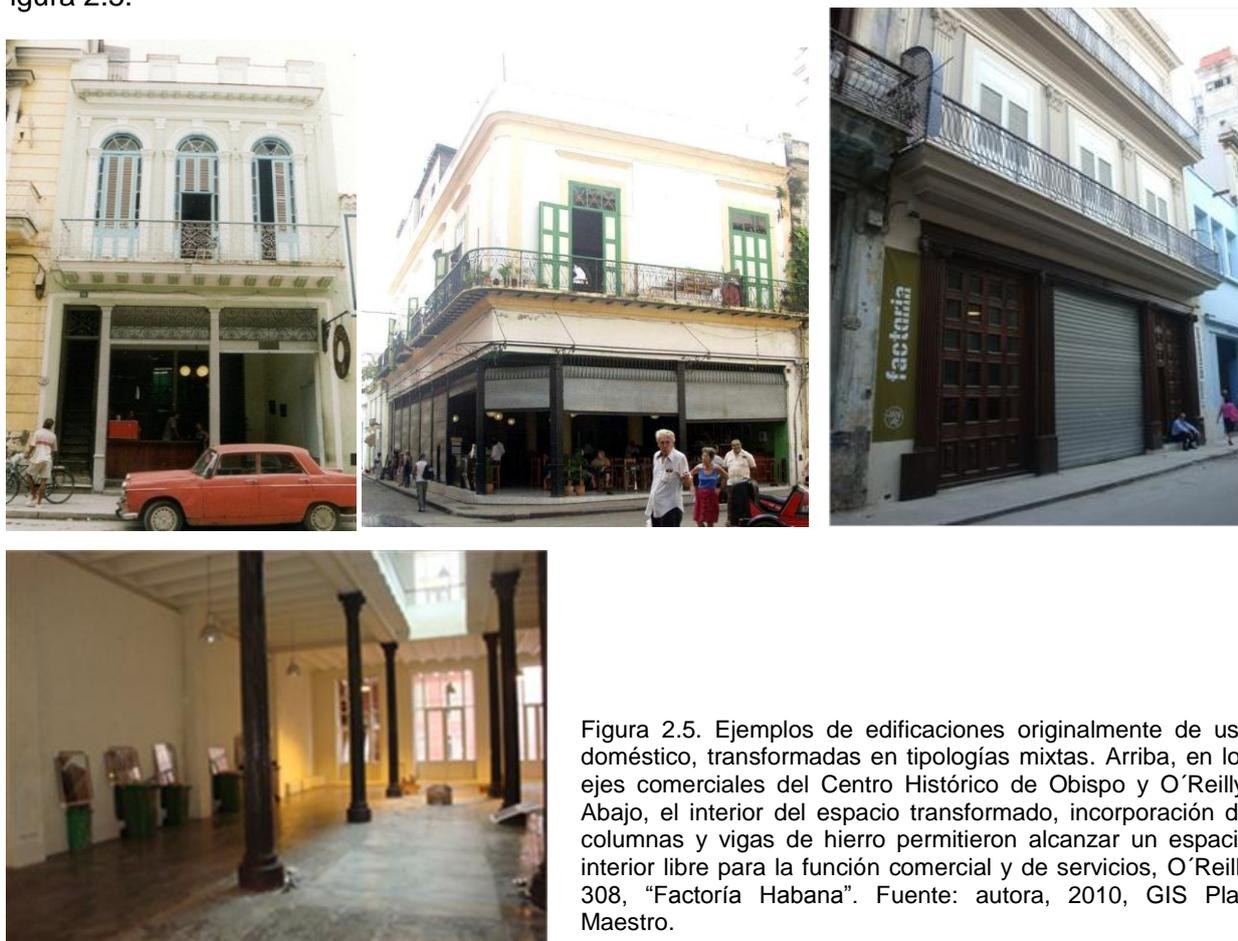
Figura 2.5. Ejemplos de edificaciones originalmente de uso doméstico, transformadas en tipologías mixtas. Arriba, en los ejes comerciales del Centro Histórico de Obispo y O'Reilly. Abajo, el interior del espacio transformado, incorporación de columnas y vigas de hierro permitieron alcanzar un espacio interior libre para la función comercial y de servicios, O'Reilly 308, "Factoría Habana". Fuente: autora, 2010, GIS Plan Maestro.
