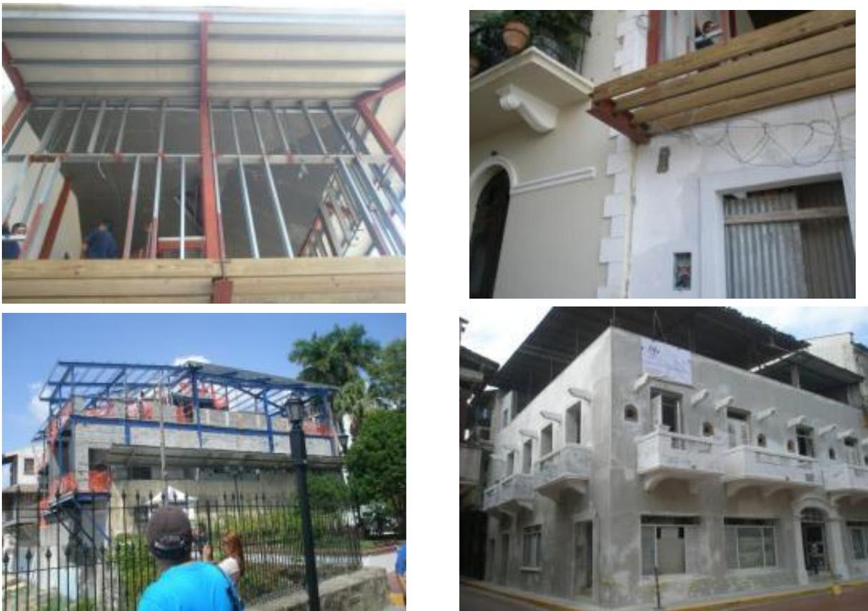
Figura 1.10. Materiales con tecnologías modernas, cubiertas ligeras empleadas en la rehabilitación de viviendas. Fuente: autora, febrero 2014.
