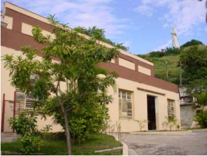
Fig. 9 Estación de Bombeo Casablanca.
